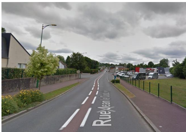
Vue sur la RD999, depuis la MFR et en direction du la ZA de la Monnerie.
