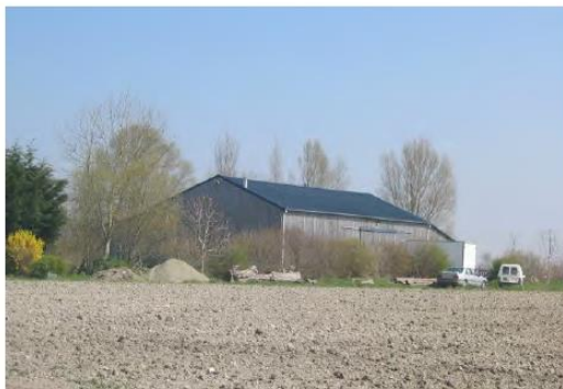
Hangar de grandes dimensions intégré par un bardage bois et quelques arbres.
