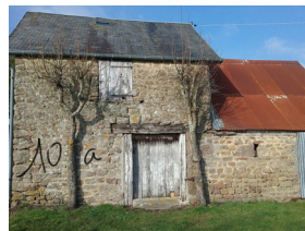
10A - La Moinerie
