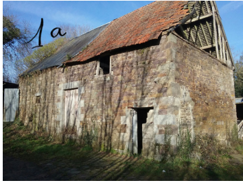
1A - Le Petit Pont SNCF
