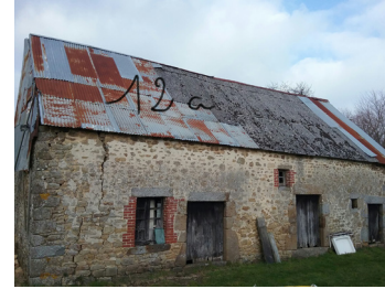
12 A - La Montellerie
