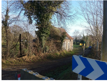
1 - Le Petit Pont SNCF
