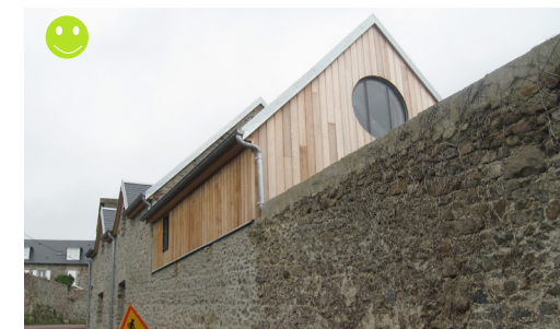
Réutiliser les murs traditionnels dans les projets
