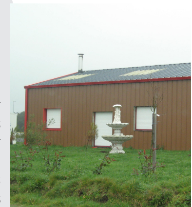
Pour une plu grande sobriété, éviter de peindre les rives d'angle des bâtiments dans des couleurs criardes
