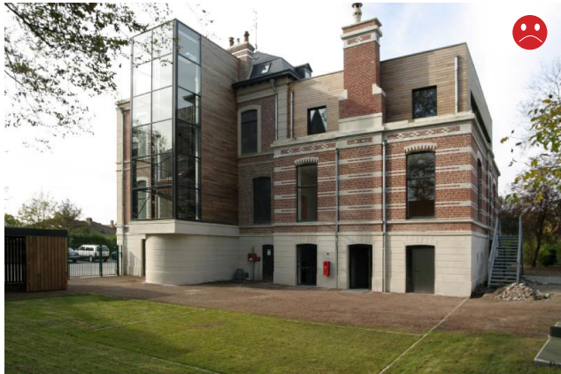
Une extension qui dénature l'architecture de la construction.
