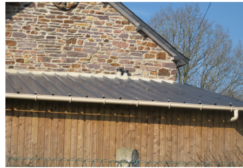
Exemple d'utilisation de bardage bois sur une extension.
