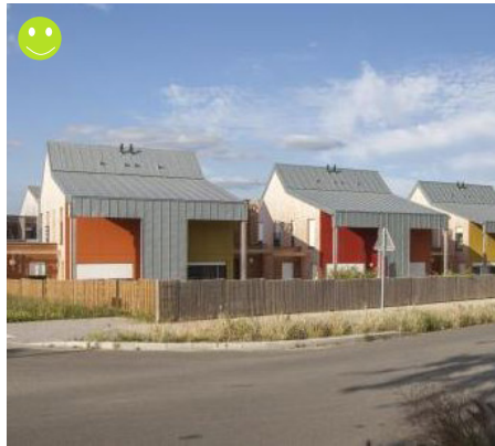
Homogénéisation des clôtures
