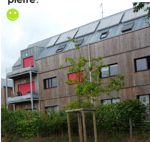
Ici, les menuiseries les châssis de toit adoptent des teintes qui s'harmonisent avec celles des matériaux de toitures et de bardage.
