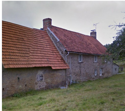
Quelques bâtiments couverts de tuiles mécaniques.
