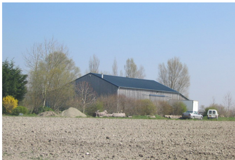
Hangar de grandes dimensions intégré par un bardage bois et quelques arbres.
