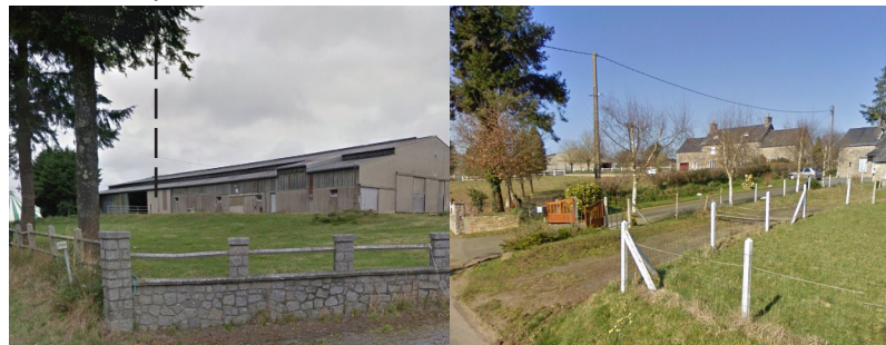
EXPLOITATION AGRICOLE BÂTI ANCIEN /BONNE CONSERVATION
