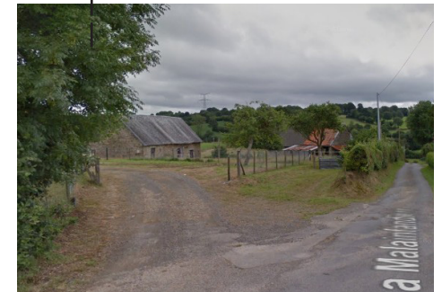
BÂTI ANCIEN /BONNE CONSERVATION
