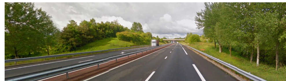
L'autoroute A 84 : mise en service en 2003, il s'agit d'un obstacle infranchissable pour les espèces.
