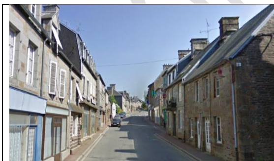
Saint-Pois : la rue principale composée de maison en R+1 avec en rez-de-chaussée des commerces ou des services. La difficulté de ce type de bâti est que l'entrée du logement est souvent lié au commerce. Pour des raisons d'accessibilité ou de dissociation des deux vocations, la rénovation du bien est difficile.
