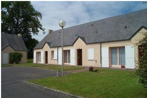
Résidence senior à Percy-en-Normandie Source : Villedieu Intercom
