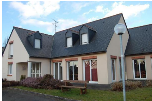
Résidence Grain d'Orge à Saint Pois Source : Villedieu Intercom
