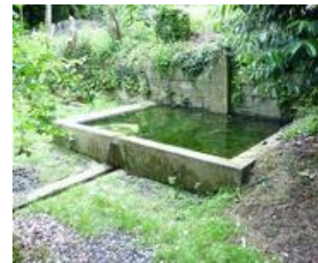
Élément de patrimoine vernaculaire - Fontaine
